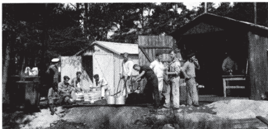
Provisoriskt kök i Trångåren, då "Göta" är på varv
