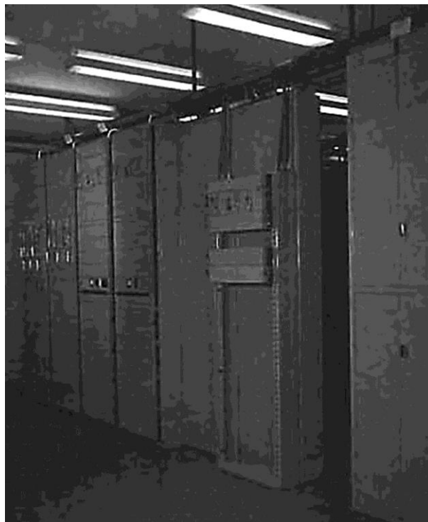
Multiplexutrustning TM-6 (Foto FHT)
