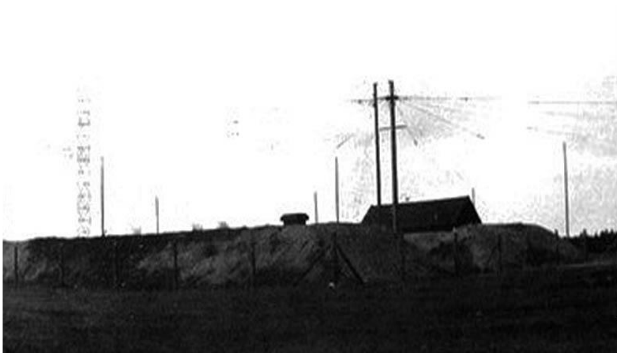
Äldre bild som bl a visar infästningen av jordnätet på stolpar och en "Rendahlsmast" till vänster. Foto från L G Stenströms samling, fotograf okänd.
