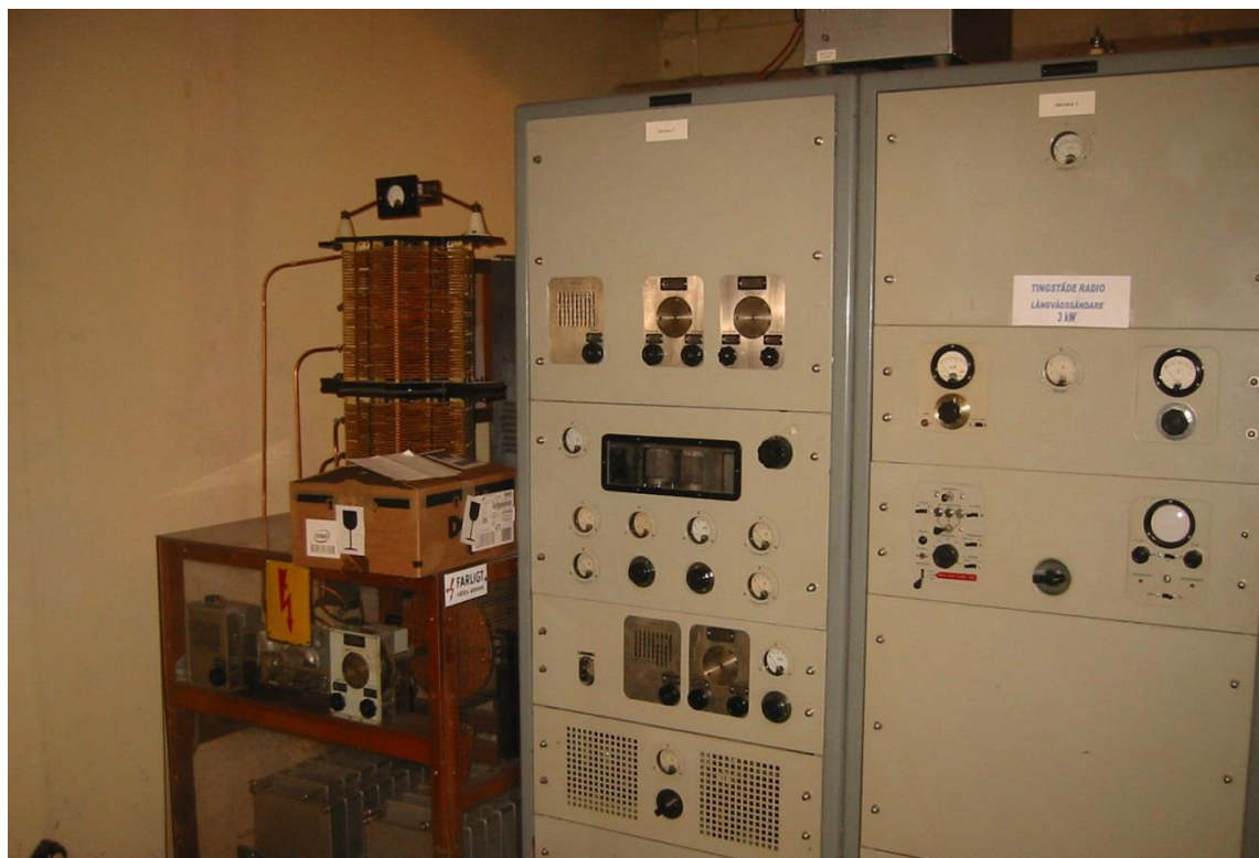
3 kW LV-sändare m/42 tillverkad av SRT, en trotjänare i marinen, blev kvar ända in på 90-talet.
