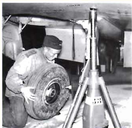
Tusentals värnpliktiga har tjänstgjort som flygmekaniker i flygvapnet. Här utför en av dem hjulbyte på en J 28B Vampire på F 8 i Barkarby 1953.
