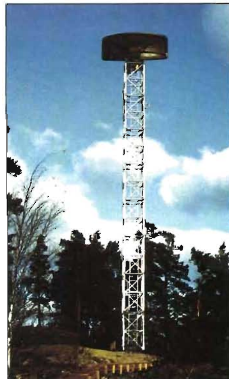
Det nya låghöjdsradarsystemet PS 870 har börjat införas. Masten är mobil i höjdled.
