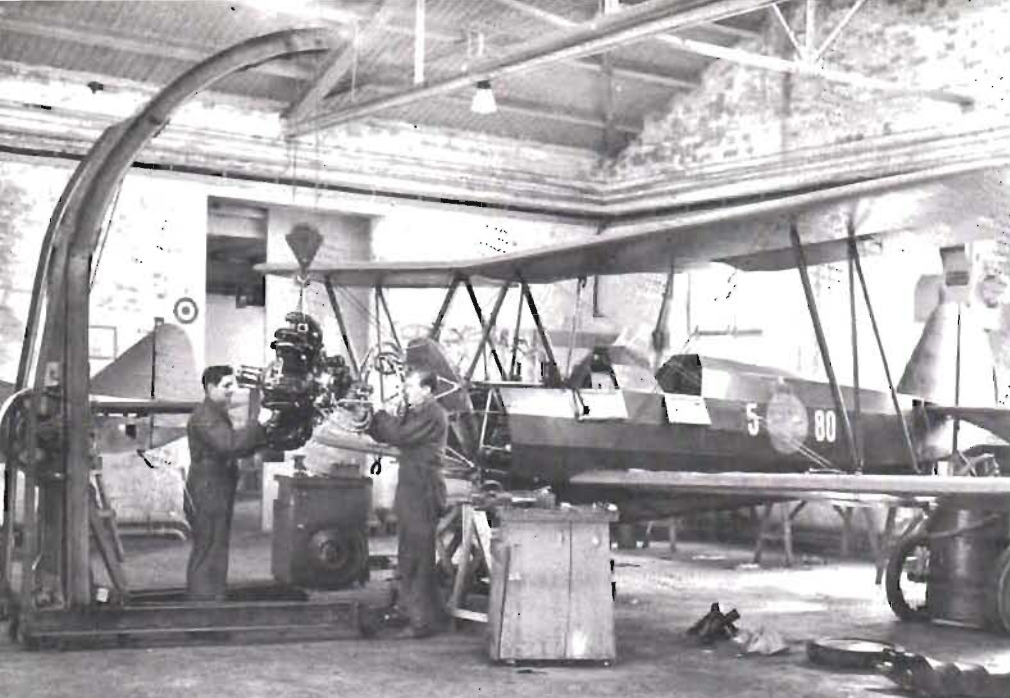
F5 1938: Monteringshallen med mekar + SK 12
