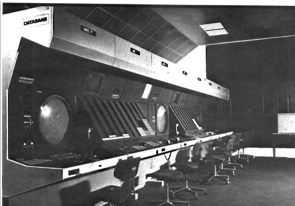
● Flygtrafikledningscentralen som den ter sig i Mineral'nyje Vodny, Sovjetunionen. De sexton arbetsplatserna är försedda med indikatorsystem för såväl radardata som färdplaner.
