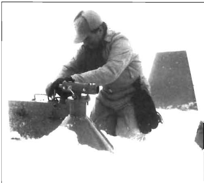
En sektorfyra monteras i början på landningsbanan. Sektorfyren ger piloten rätt inflyttningshöjd vid mörkerlandning.
