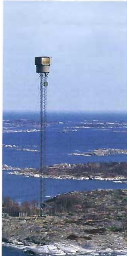
Radarstationer av typ PS-15 användes för spaning på låg höjd.
