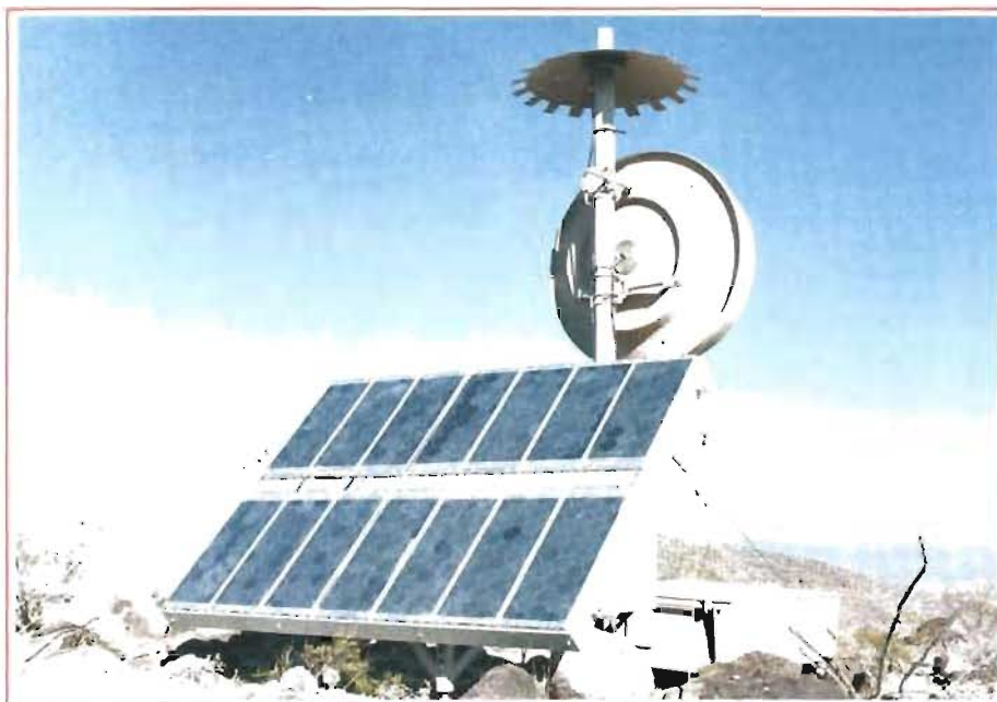
Övan: Soldriven sökstation för mikrovåglänkning
