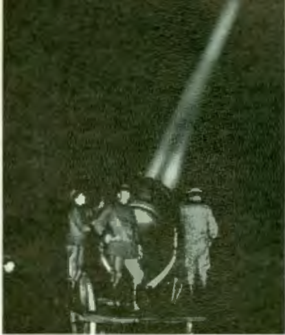
Övning med strålkastare — tidigt 30-tal.
