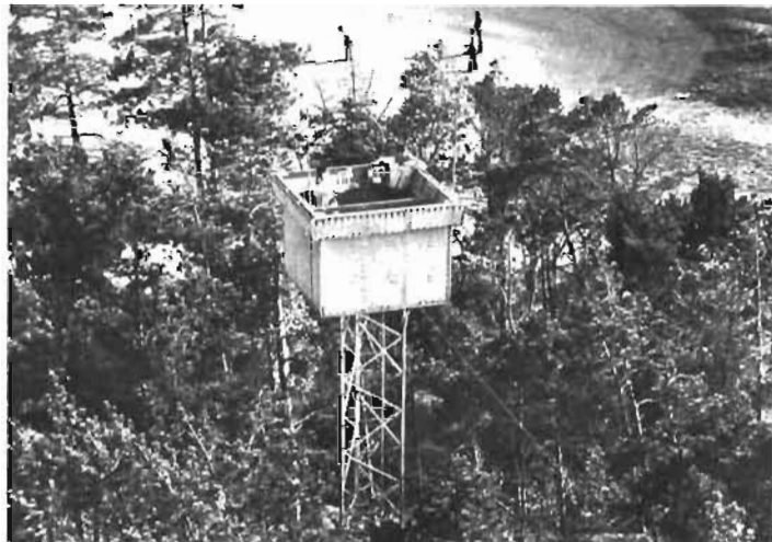
Från Ls-torn upptäcks och inrapporteras olika verksamheter som t ex kärnladdningar, luftlandsättningar, bombfällning, olika sjö- och markiakttagelser. Men främsta uppgiften är flygplanrapportering. Detta är speciellt viktigt för luftförsvaret på låg höjd, under radartäckning eller om radarstation blivit obrukbar. - I detta fall "någonstans i Sverige" bemannad av Tony Johansson (Edsbyn) och Anders Stjernqvist (Glimåkra).
