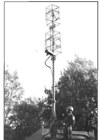
Ovan: Upprättning av sändarmast.
