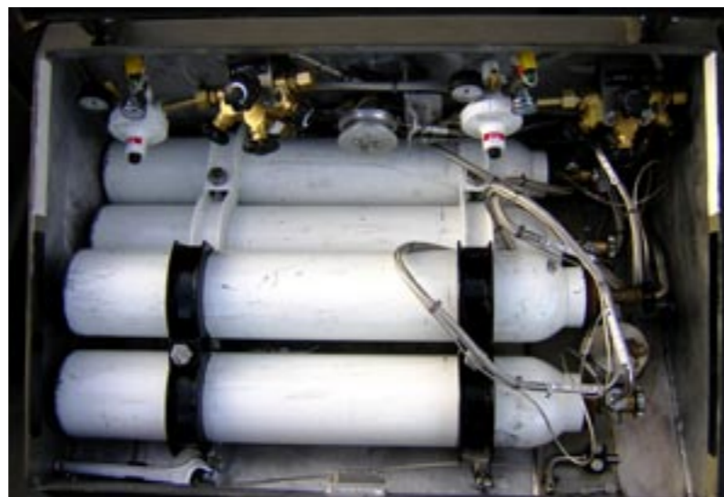
Syrgas är en nödvändighet för att kunna hjälpa patienter med andningsproblem. Tuberna har placerats på däck ifall brand skulle uppstå på båten. En knapptryckning från hytten är allt som behövs för att tuberna automatiskt ska dumpas över bord.
