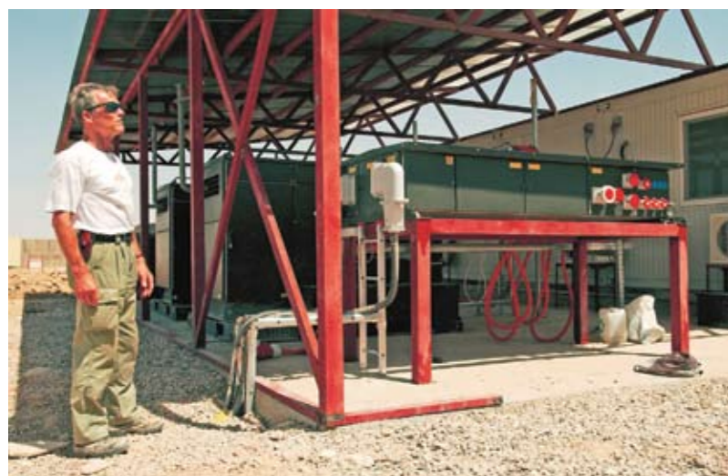
Mitt på campen står reservkraftssystemet. Såvida inget omfattande händer, kommer det dock aldrig att behöva användas.
