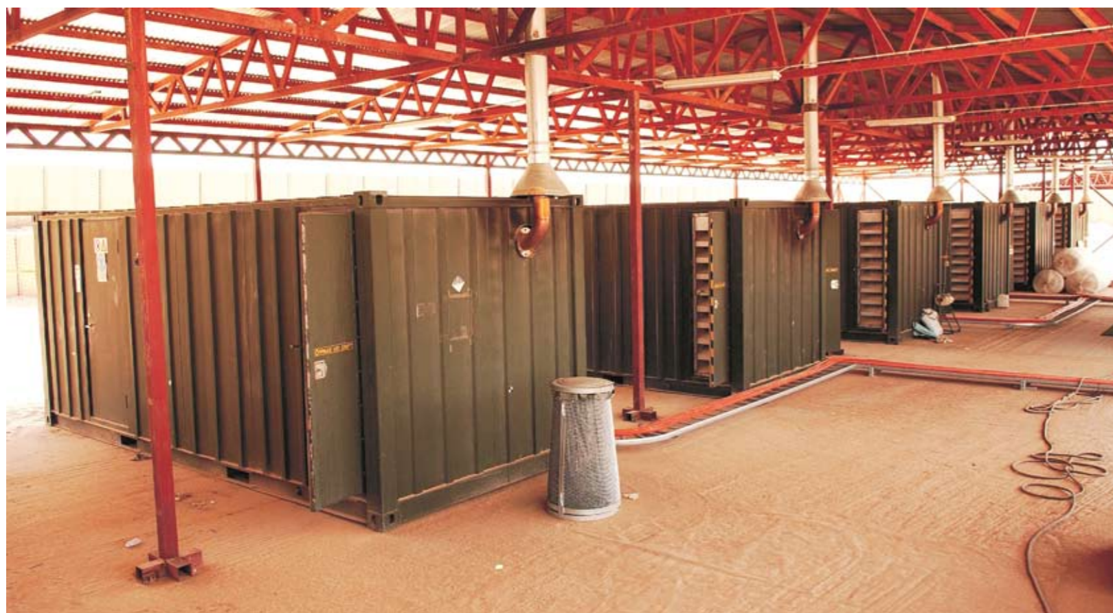
Hes-systemets sex elverkscontainrar kan leverera 1.800 kilovoltampere, vilket är nog för att driva ett helt villaområde.
