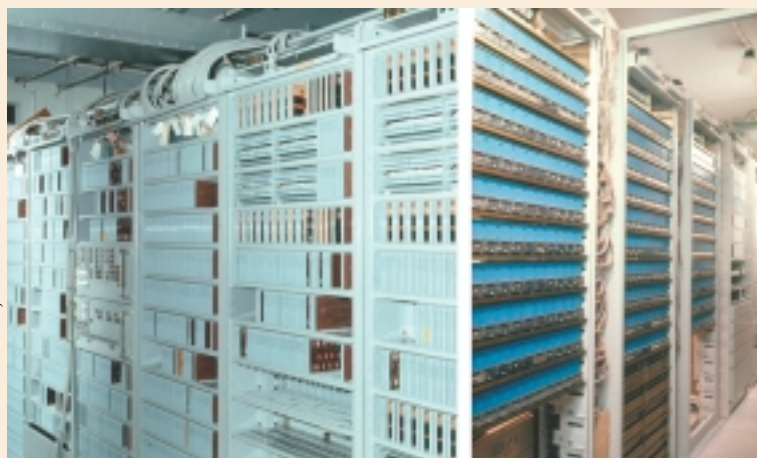
AKE-129, den första programminnesstyrda telefonväxeln i FTN var i drift i ATL 1969-1994
