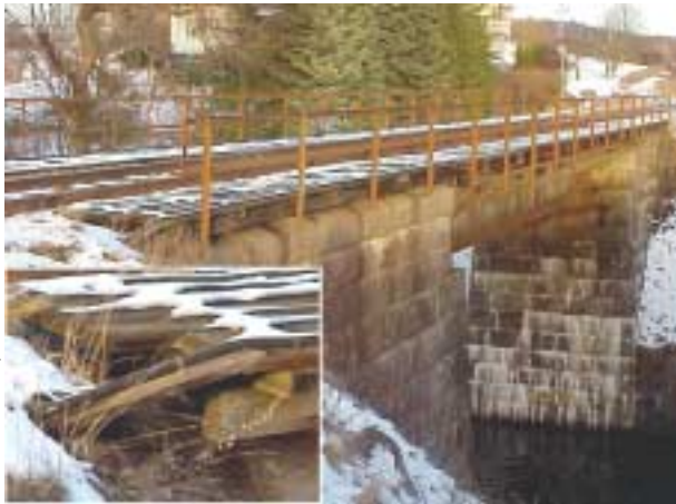
I publika nät är ekonomin starkt styrande. Exempel på svagt skyddad förläggning av optokabel
