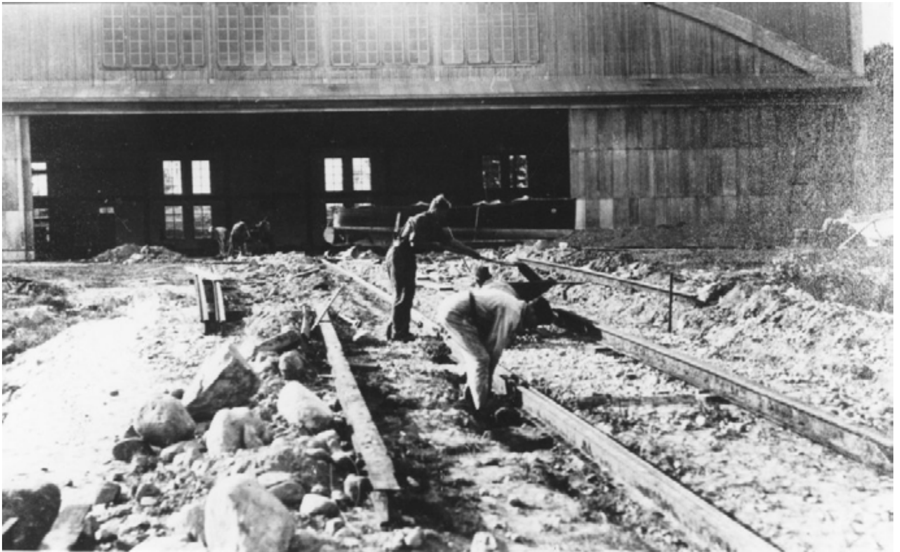
Slipen framför hangar 81 gjutes år 1935.
