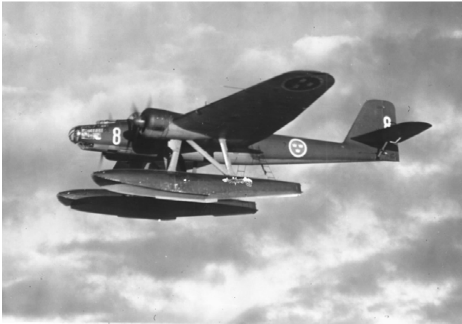
T 2, Heinkel He 115, i luften, märkt 8 på fena och nosen. Fanns vid F 2 Hägernäs 1939 - 1949. Användes för torpedfällning, minfällning, bomber eller för att lägga ut dimma.
