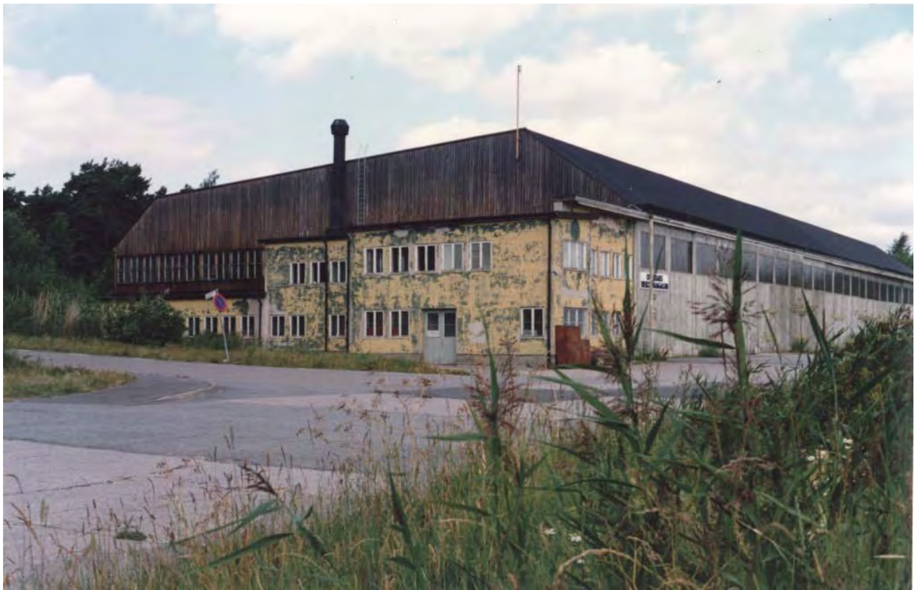
Hangar 82, byggdes 1938-1939. Riven för nybyggnation.
