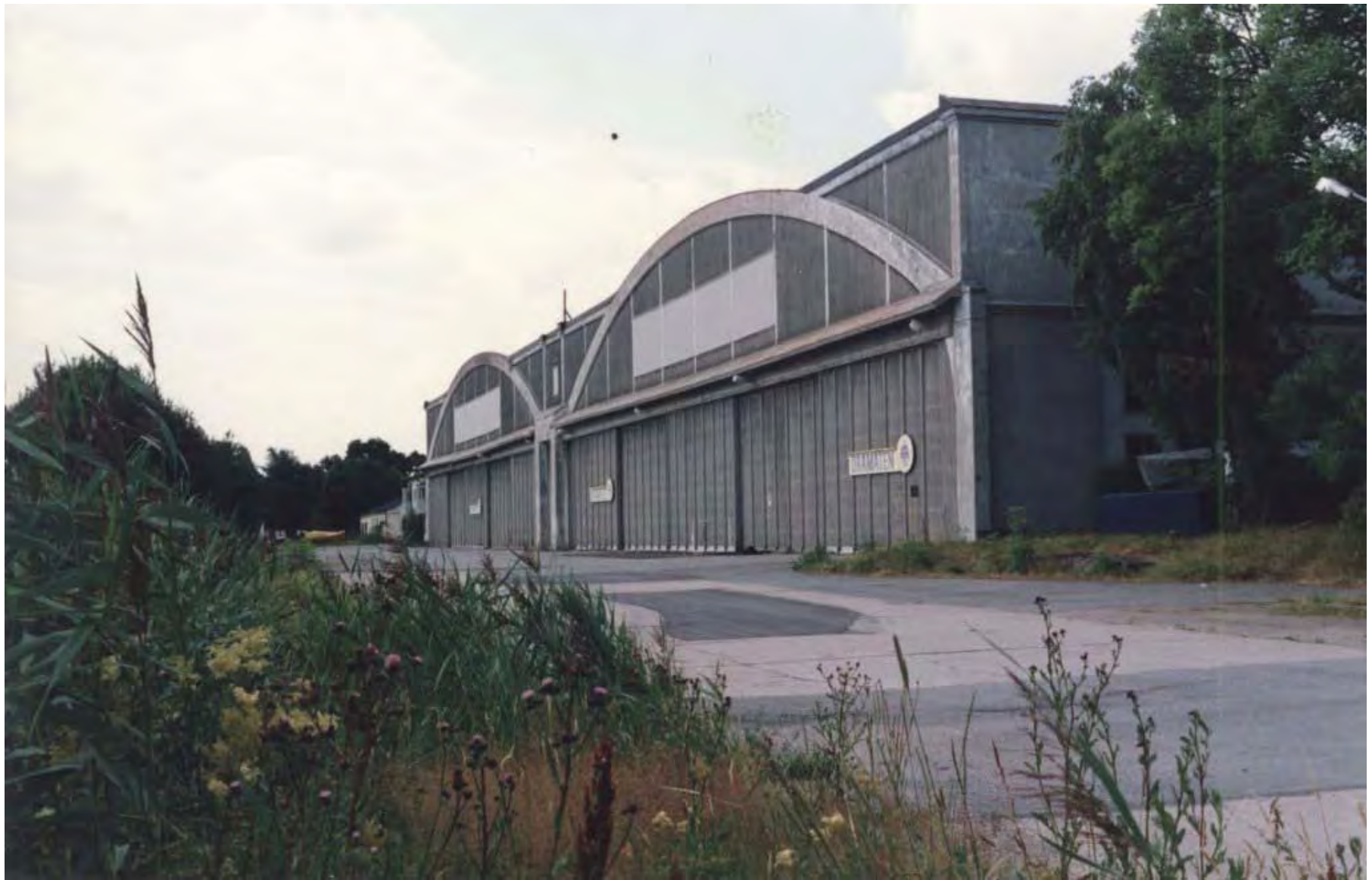
Hangar 81 på F 2, Hägernäs. Byggdes 1927. Avses vara kvar som parkeringshus
