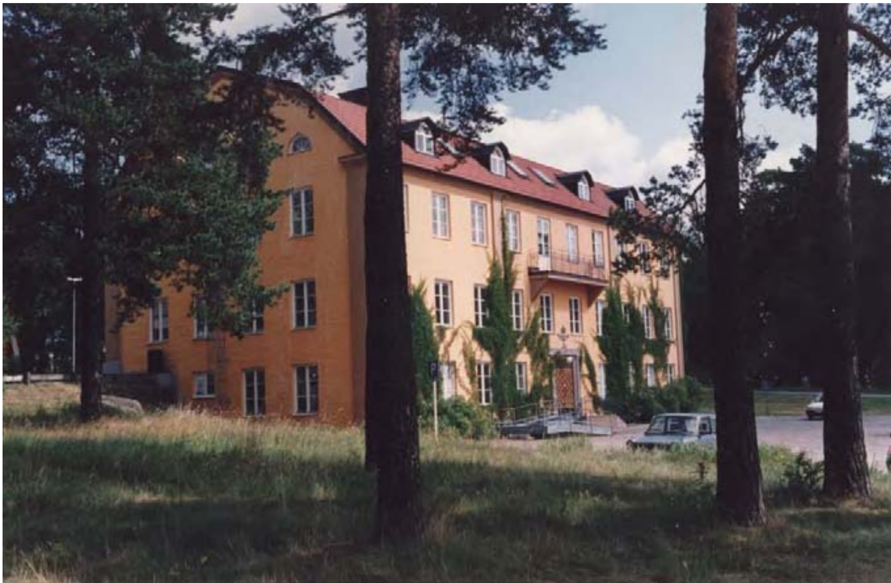
Kanslihuset baksida på F 2 Hägernäs i början av 1990-talet. Byggdes 1928, är K-märkt.
