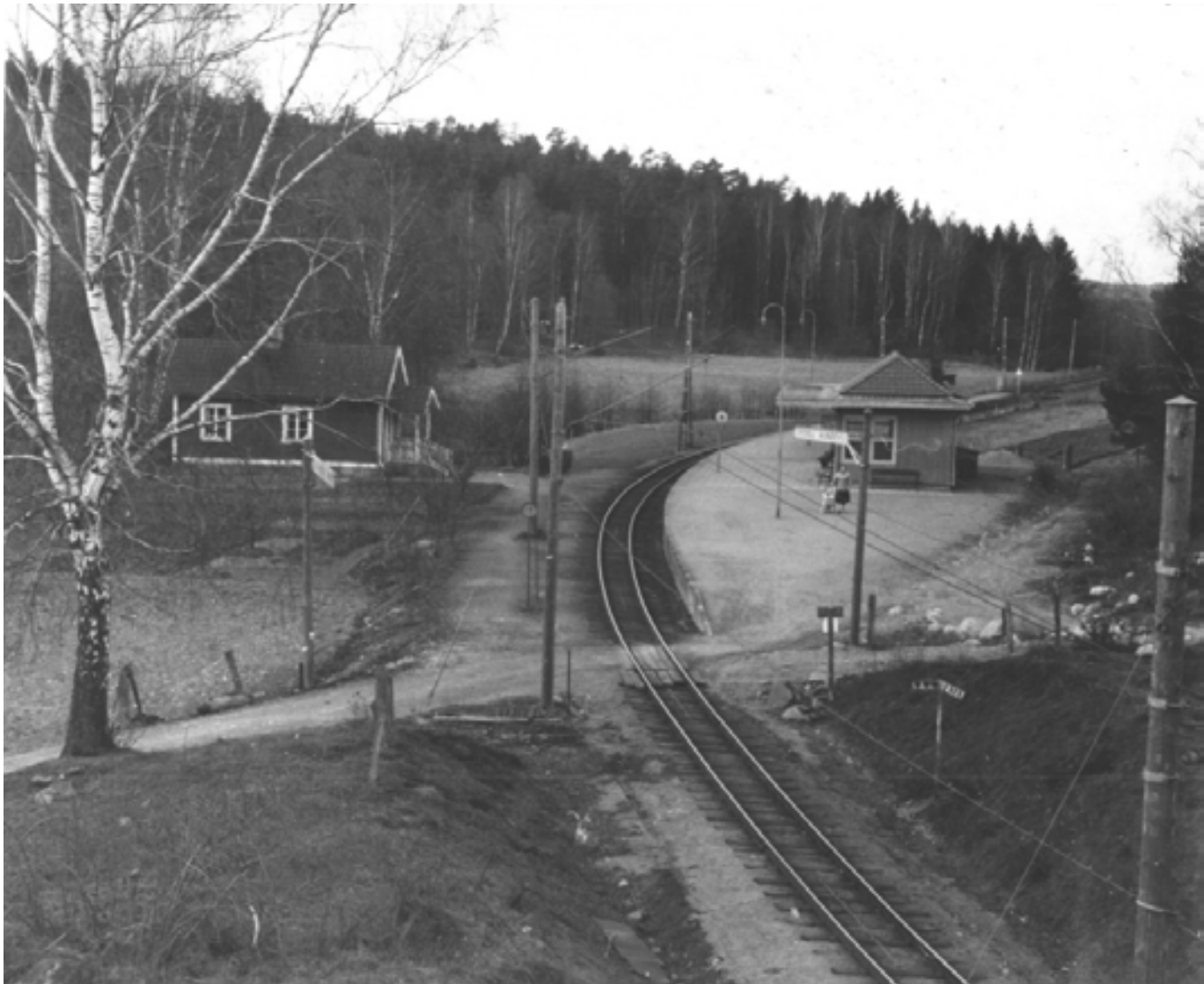
Roslagsbanans passage vid Hägernäs hållplats. Både hållplats och den vackra banvaktstugan försvann på 1960-talet.
