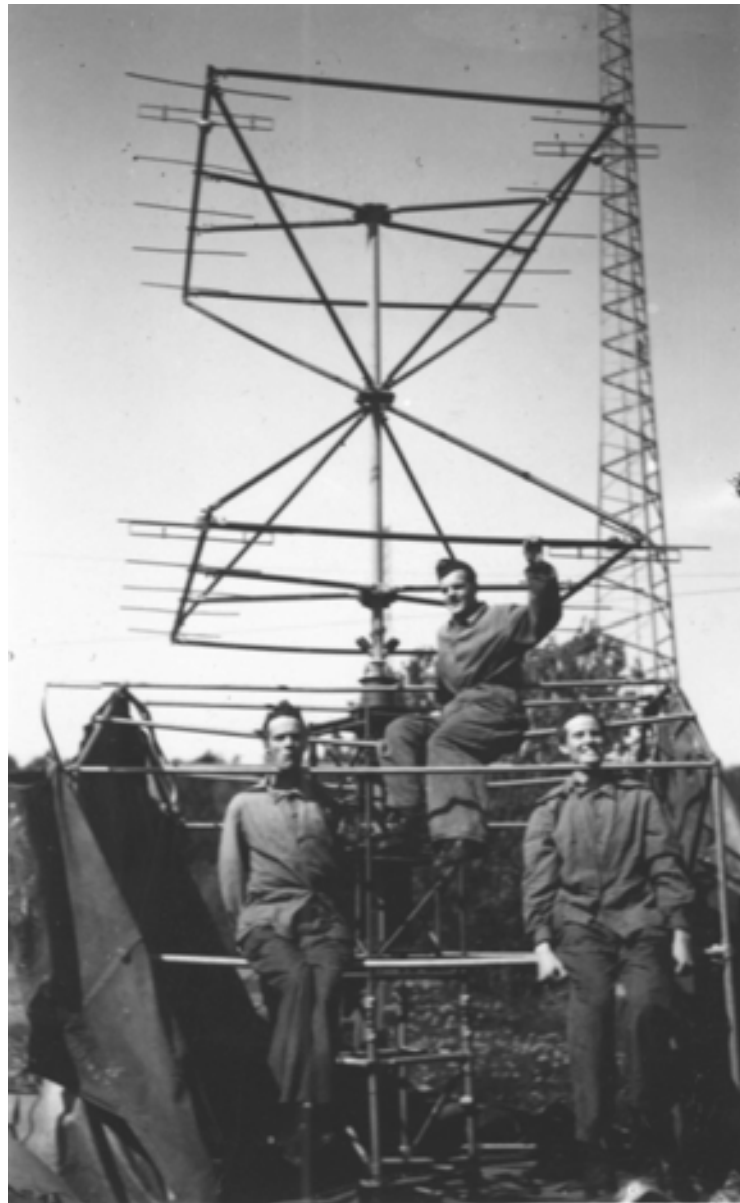
Radarstationen ER IIIB monteras upp utanför barack 34 på F 2 Hägernäs. Fr.v. G Olsson, B Linderoth och B Rolker.
