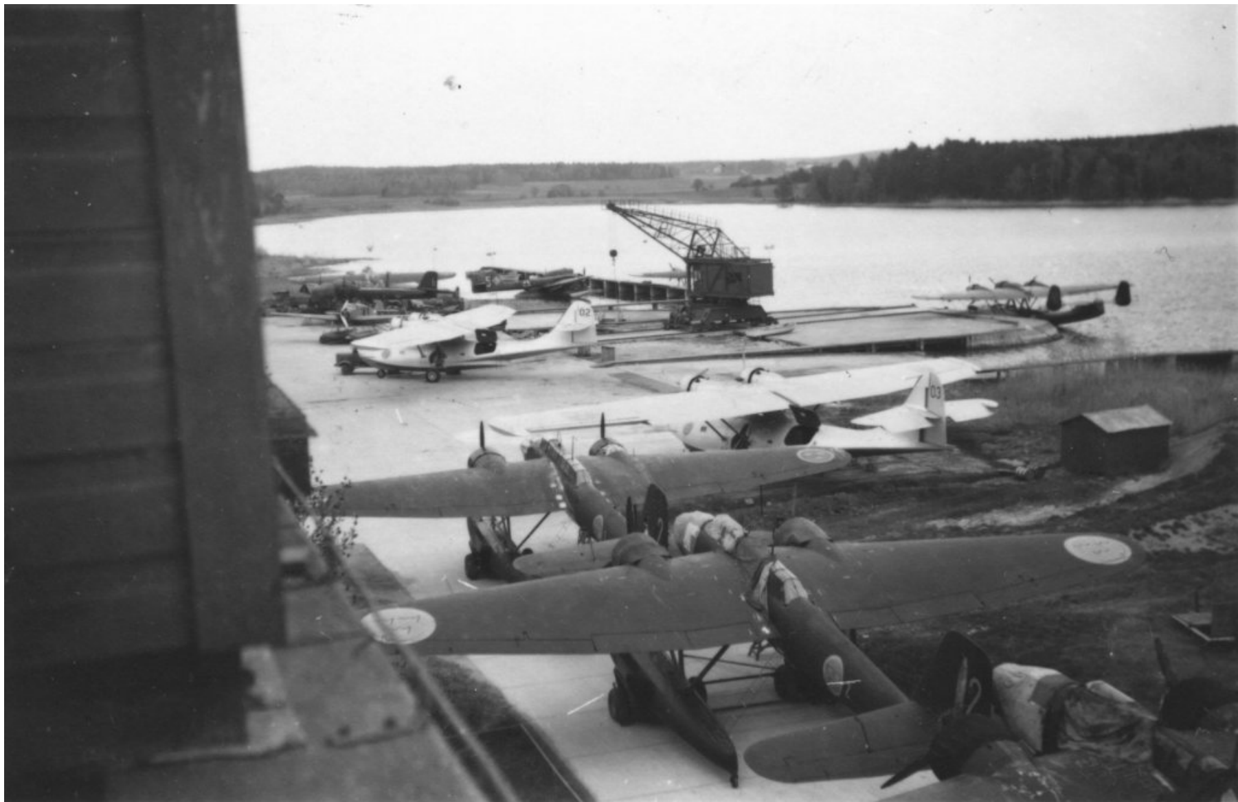
Foto taget från radarstationen ER IIIB på hangar 81:s tak på F 2, Hägernäs hösten 1948. Fin utsikt över hangarplattan med T 2 Heinkel He 115 och Tp 47 Catalina.
