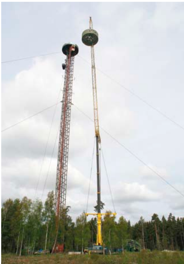
Nedlyftning av apparathuset från bottenplattan med en hydraulisk mobilkran försedd med fackverksjibb och med minst 120 meters lyfthöjd.
