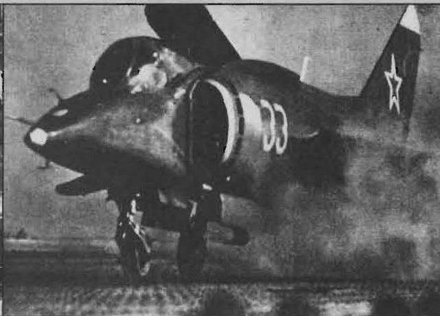
Hangarfartyget "Kiev" är, förutom hkp och rb, utrustat med flyg: Jak-36 "Forger" A+B. På sistone har "Forger" modifierats ovanför vardera sidoluftintag; två långsgående metallstråk kringgärdar upptill luftintaget till den kroppscentralt placerade lyftmotorn.
