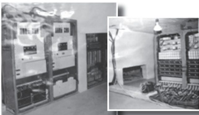
Strömstativ med batterier
