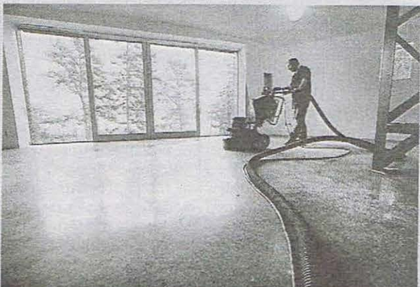
PUTS. Otto Segerros gör sista poleringen av betonggolvet.
