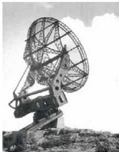
Bild 6. En Würzburg Riese-antenn monterad som radioteleskop på Råö.
